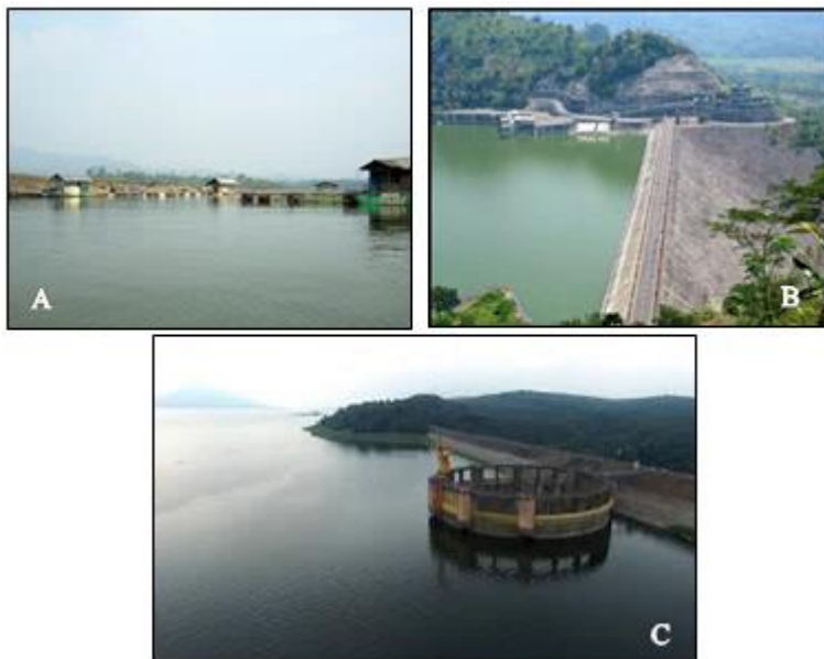
Gambar 2.31. Waduk Saguling (A), Waduk Cirata (B), dan Waduk Jatiluhur (C) yang dibangun pada alur S.Citarum di Jawa Barat ( https://www.google.co.id )
